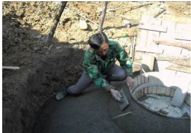
照片 9 修建沼气池
