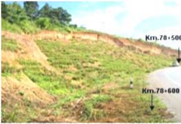
图 11 107 号公路的开挖斜坡被香根草稳定下来，阻止了泥土流的发生（2007 年）
