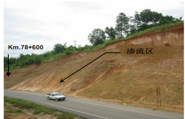
图 14 应用香根草系统将土壤水饱和的公路斜坡稳定，防止泥土流流动
