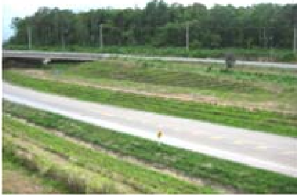
图 1 种植香根草稳定公路背坡 (开挖坡)
