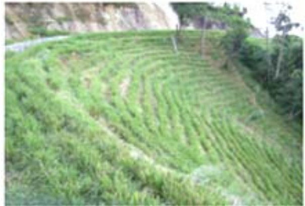
图 2 种植香根草稳定公路边坡 (路基坡)
