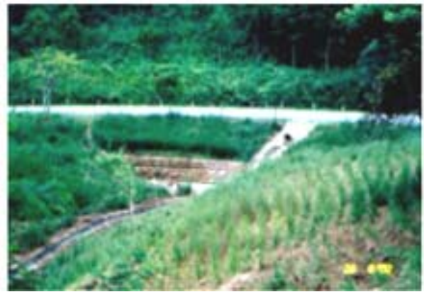
图6 在修路工程中结合砌石墙布置香根草系统
