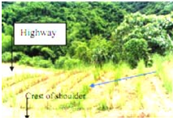
图5 在坡度较陡的公路路肩上种植香根草，减缓纵向的径流
