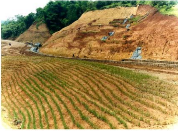
图7 在公路建设工程中，香根草作为先锋植物种植在裸土上
