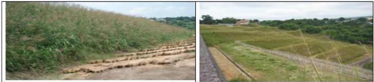
照片 13 和 14: 拍于 2011 年 5 月。拍照地点与照片 11 与 12 地点相同。香根草绿篱防止了所有侵蚀发生, 设施在超过 70mm 的豪雨冲击下亦安然无恙。
