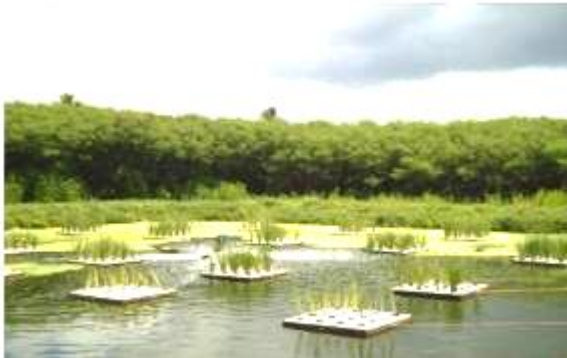
图 5 2008 年 7 月, Inarajan 污水处理厂初栽的香根草
