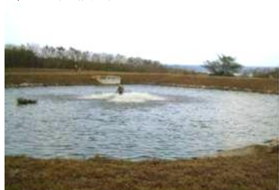
图 2 Inarajan 污水处理厂，每一个池都有一台水面机械充气机每日 24 小时不间断充气 (右)
