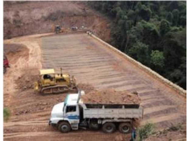
用泥土填充墙体
