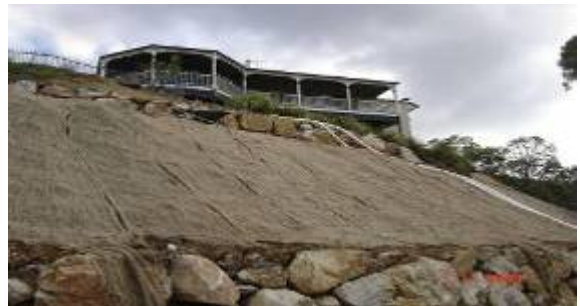
图11 修复后的房基前坡，上盖麻布网
