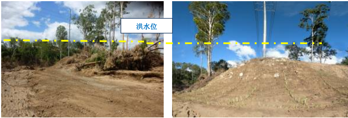
图 5 洪水摧毁的电杆基础 (左) 电杆修复后栽上香根草 (右)
