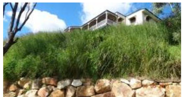
图12 香根草种植两年之后，房基受到完全保护
