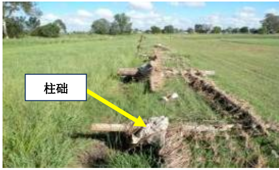
图 1 激流将此混凝土篱柱础拔起（左）并将此集装箱从上游 23km 处冲到此处（右）
