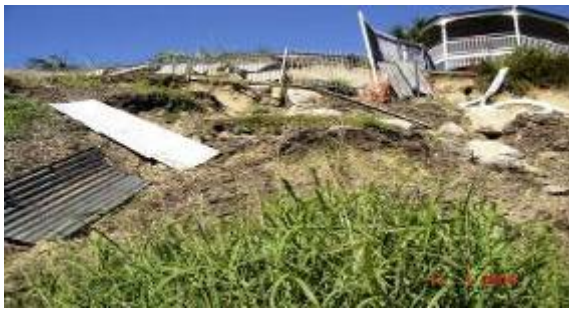
图10 这座房子建在陡坡丘顶，其房基受滑坡威胁
