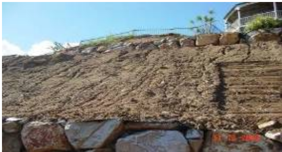
图11 修复后的房基前坡，上盖麻布网
