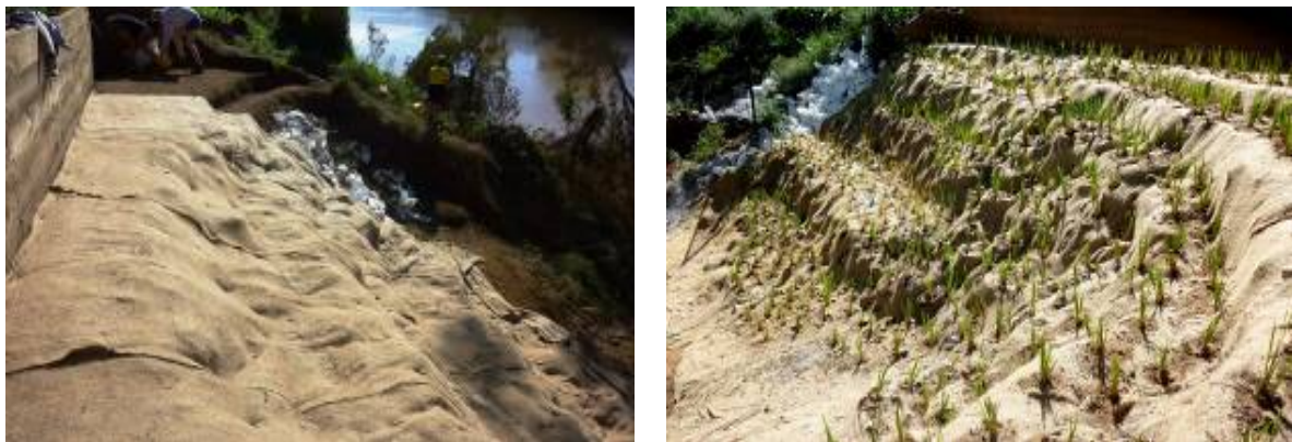
图 8 沙土包上覆盖麻布网 (左), 以期在水位上升时得到暂时保护, 之后种上香根草 (右)
