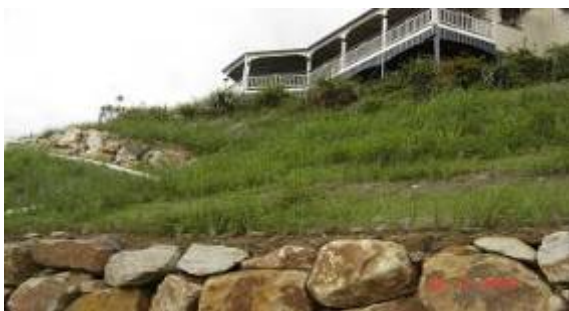
图12 香根草种植两年之后，房基受到完全保护
