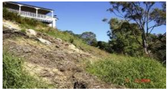
图10 这座房子建在陡坡丘顶，其房基受滑坡威胁
