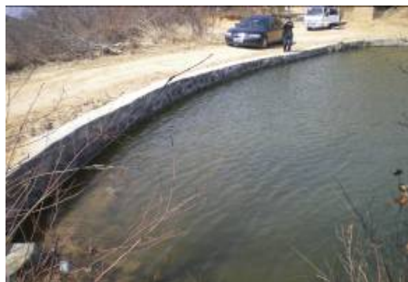
修好的水塘正常蓄水
