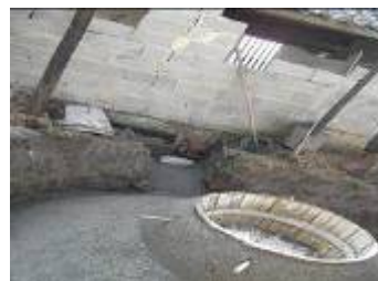
即将修好的沼气池
