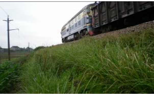
照片 3. 7 年后香根草固定铁路路基的效果（摄于 2007 年 4 月）
