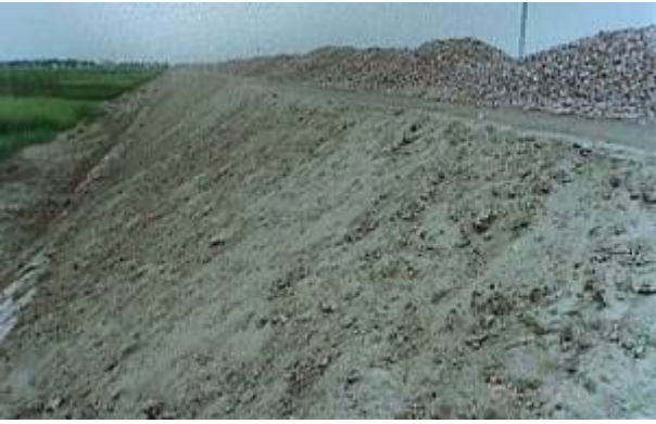
照片 1. 用水稻田中的沙土堆起的路基（2001 年初）
